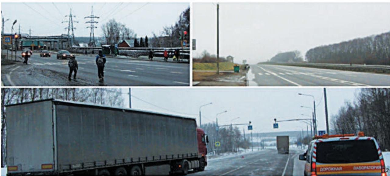
Аварийно опасные участки дороги и потенциально опасные места на автомагистрали М-4 «Дон»
